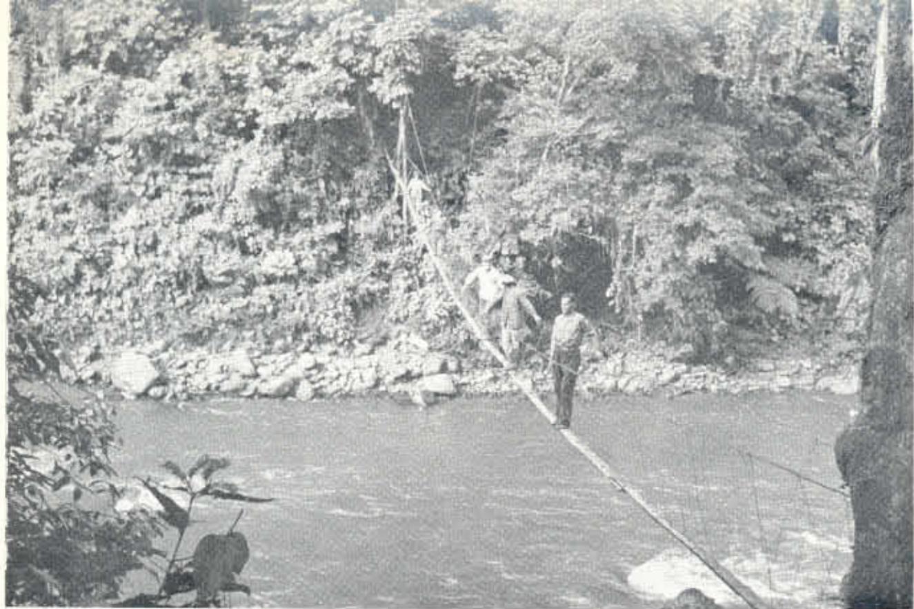
1. Paso aéreo sobre el río Mira por medio de un puente colgante de tablas de "pambil" sostenidas por alambres. Sector de Guadual-Piguambi, kilómetro 287 del ferrocarril Quito - San Lorenzo. Foto MAS: septiembre 12, 1960.
